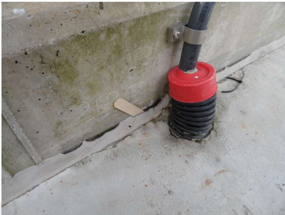
Foto: Gebrek aan afdichting.
