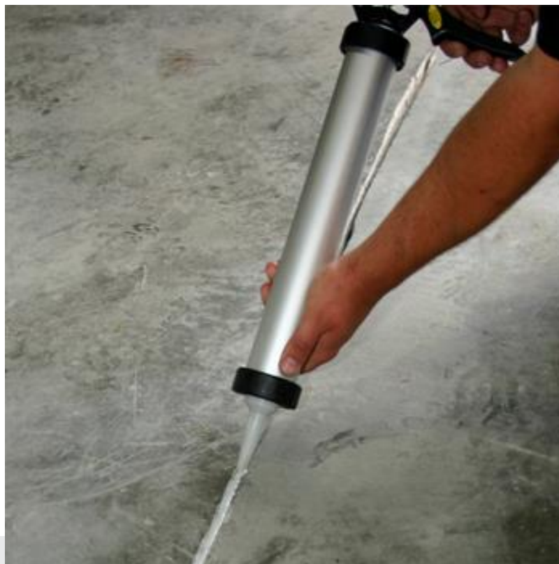
Foto: Aanbrengen voegmassa.
